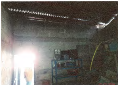
Foto1: Se ampliará la cocina, levantar cubierta de lamina, pintar estructura, pintar lamina, bajar el nivel del suelo, repellar, pintar, instalar pila elaborar gabinetes prefabricados.
