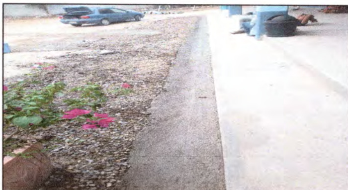
FOTO 8: SE REALIZO REPARACION DE CUNETETA DE CONCRETO
