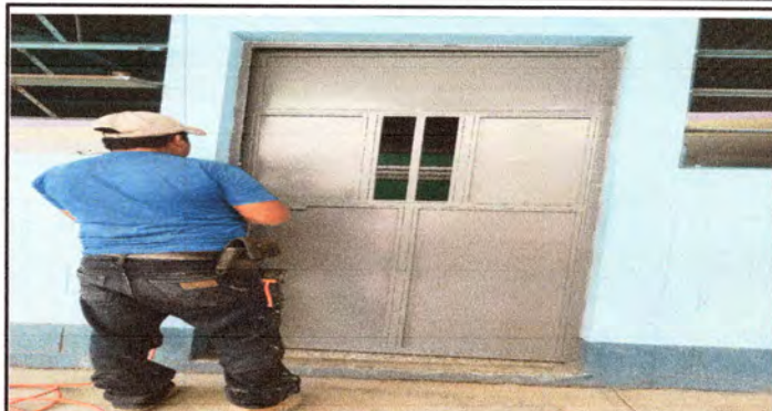
FOTO 7: SE REALIZO LA REPARACION DE PUERTAS.
