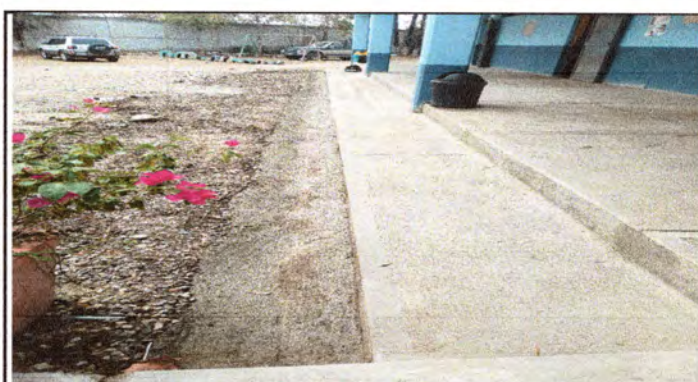
FOTO 9: SE REALIZO REPARACION DE CUNETETA DE CONCRETO.
