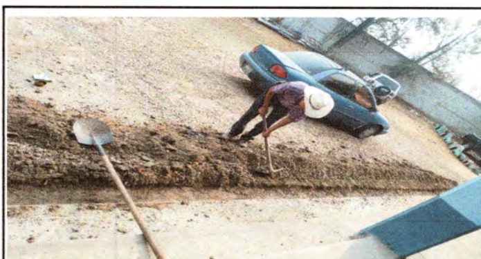
FOTO 10: REALIZANDO LA REPARACION DE LA CUNETA DE CONCRETO.
