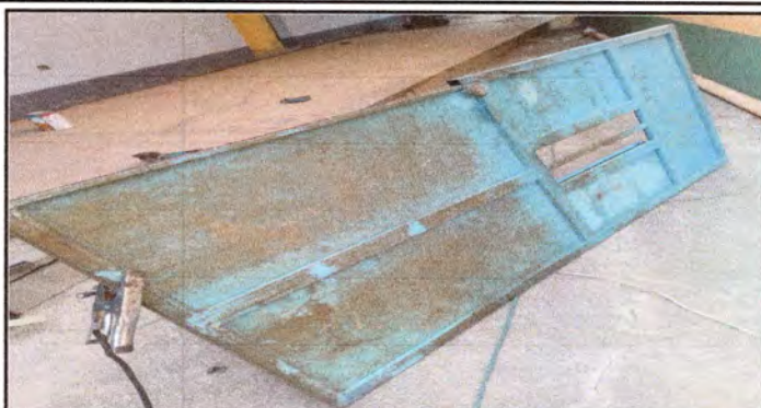
FOTO 8: REALIZANDO LA REPARACION DE PUERTAS.
