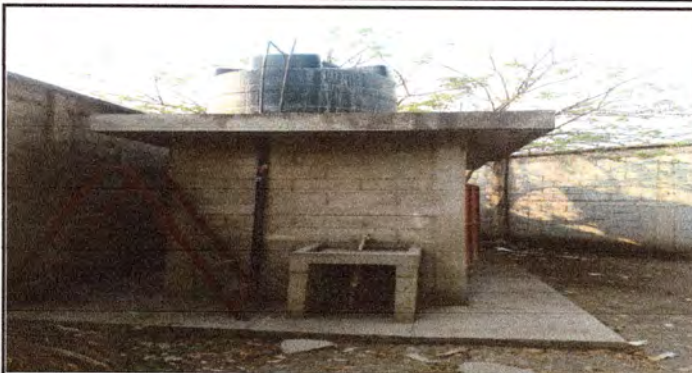
FOTO 7: SE REALIZA LA REPARACION Y MANTENIMIENTO DE CISTERNA/DEPOSITO DE AGUA POTABLE.
