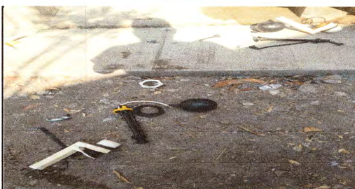
FOTO 12: SE REALIZA LA REPARACION DE BAÑOS.
