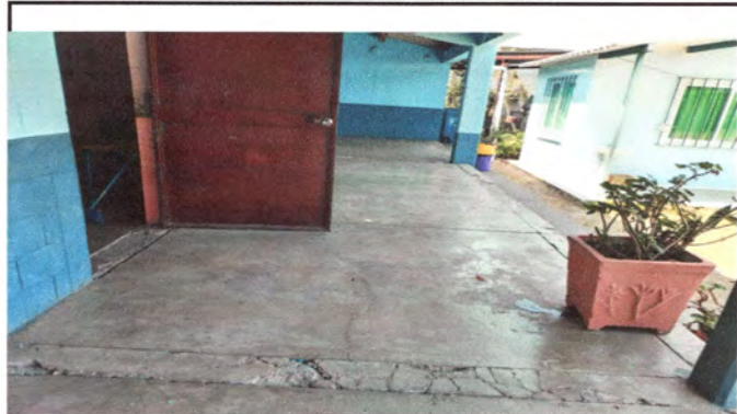
Foto 9: SE REALIZARA REPARACION DE PUERTAS.
