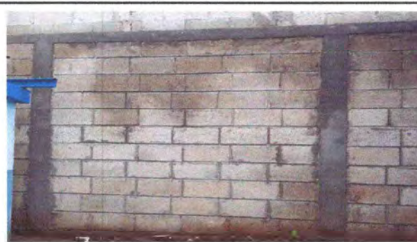
Foto 4: MURO PERIMETRAL (SUSTITUCIÓN BLOCK)
