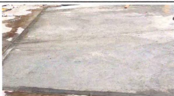
Foto 5: LOSA DE PATIO (SUSTITUCIÓN BASE FUNDICIÓN Y ACABADO)
