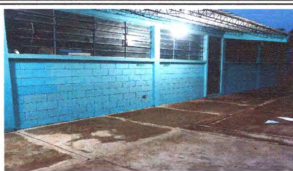
Foto 2: PINTURA (MÓDULOS EXTERIORES)
