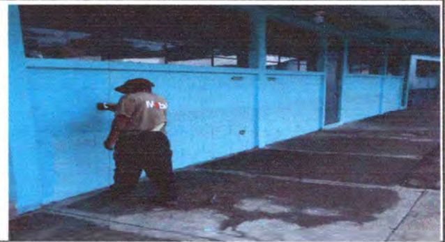
Foto 2: PINTURA (MODULOS EXTERIORES)
