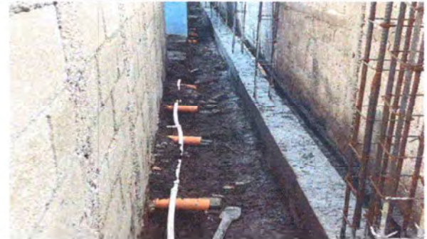
Foto 4: MURO PERIMETRAL (SUSTITUCIÓN BLOCK)
