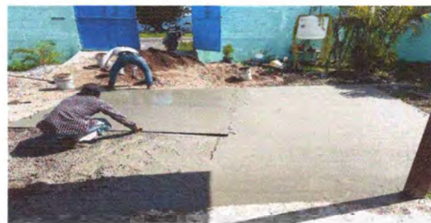
Foto 5: LOSA DE PATIO (SUSTITUCIÓN BASE FUNDICIÓN Y ACABADO)
