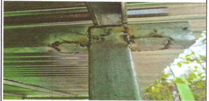
Foto 2: LA ESTRUCTURA EXISTENTE SERA SUSTITUIDA Y ESTARA DISEÑADA POR UN SISTEMA DE TIJEAS CON COSTANERAS, MAS PEDESTALES TIPO COLUMNA RIGIDIZANTE EN EL MARCO.
