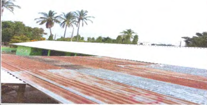
Foto 1: LA LAMINA SERA SUSTITUIDA POR LAMINA TROQUELADA A DOS AGUAS + CAPOTE
