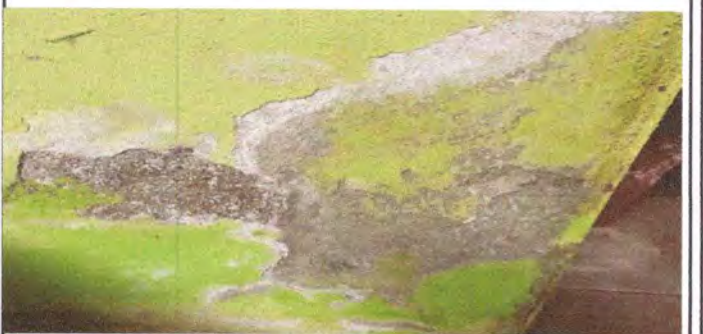
Foto 6: SE SUSTITUIRA REPELLO + CERNIDO.
