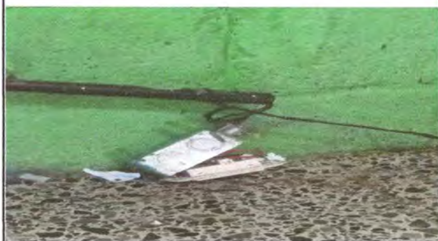
Foto 7: SE LE DARA MANTENIMIENTO AL SISTEMA ELECTRICO
