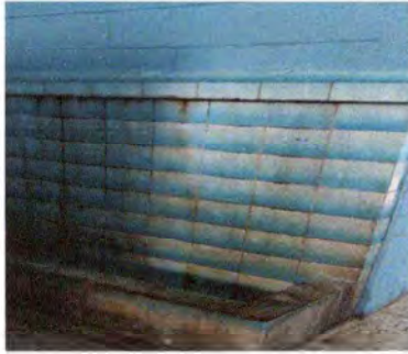
Foto7: Reparación o sustitución de azulejo (Mantenimiento de limpieza a mingitorios)
