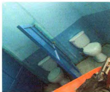
Foto 5: Mantenimientos de tazas de sanitarios baños.
