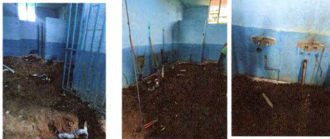
Foto1: Reparacion de red de drenaje agua pluvial baños.
