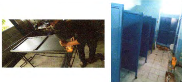
Foto3: Mantenimiento de puertas de baños.
