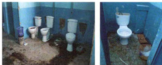
Foto4: Sustitución de tazas sanitarias.
