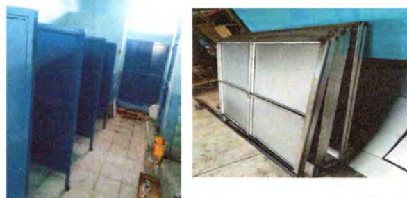
FOTO 2: Reposición de puertas de sanitarios.
