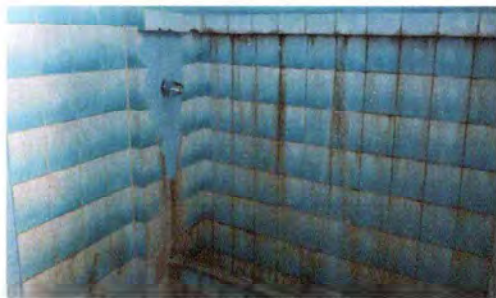
Foto7: Reparación o sustitución de azulejo (Mantenimiento de limpieza a mingitorios)
