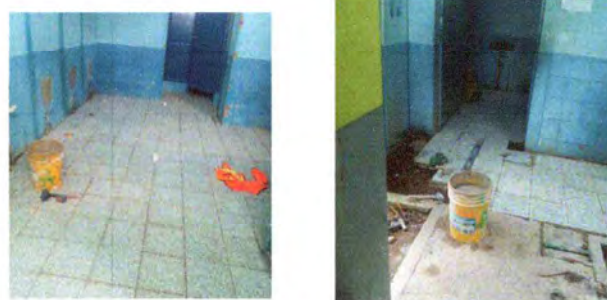
Foto: 6 Reposición de piso
