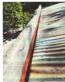
Foto 6: Impermeabilización de canal de concreto
