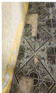
Foto1: Sustitución piso cerámico
