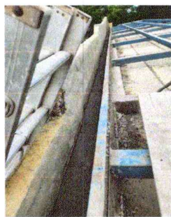
Foto 6: Impermeabilización de canal de concreto
