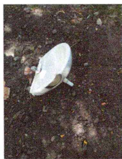
Foto 5: Reposición de tasas sanitarias y lavamanos
