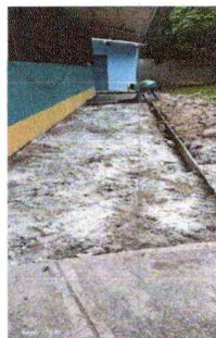
Foto 2: Sustitución de área de base y piso cerámico
