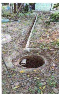
Foto 3: Sustitución de red de drenaje
