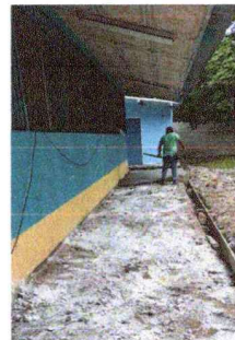
Foto 2: Sustitución de área de base y piso cerámico
