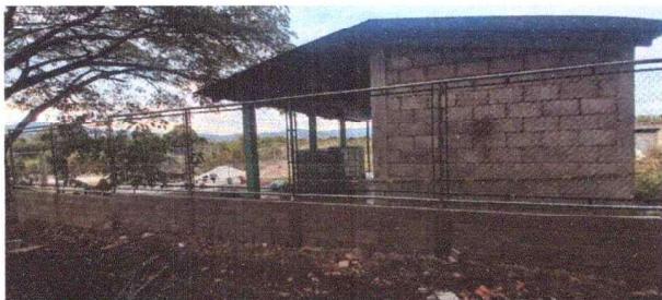
Foto 3: Malla terminada a un lado de la escuela.
