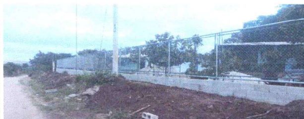
Foto 2: Malla terminada lado de enfrente de la escuela.
