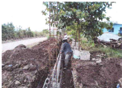
Foto 3: Puesta de block del muro, lado de enfrente de la escuela.
