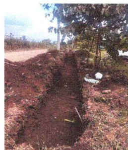
Foto 2: Zanjeo del muro perimetral.
