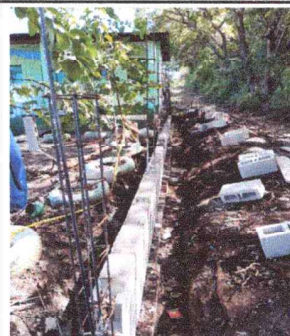
Foto 4: Puesta de block del muro, a un lado de la escuela.
