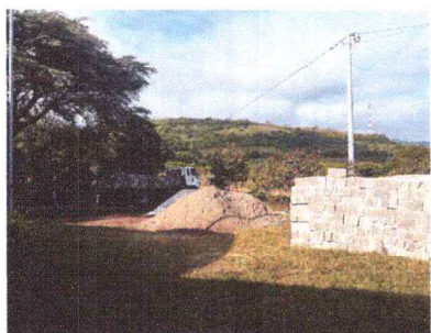
Foto1: Material a utilizar para remozamiento.
