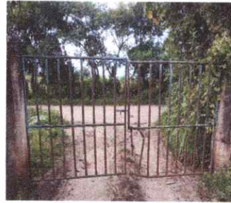
Foto 2: SUSTITUCIÓN DE PORTON DE TUBO CON MALLA
