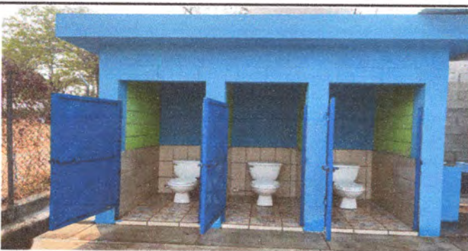
Foto 5: MANTENIMIENTO DE BAÑOS Y CAMBIO DE ACCESORIOS
