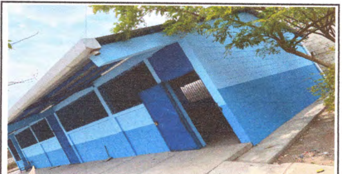
Foto 4: APLICACIÓN DE PINTURA EN AULAS POR DENTRO Y FUERA
