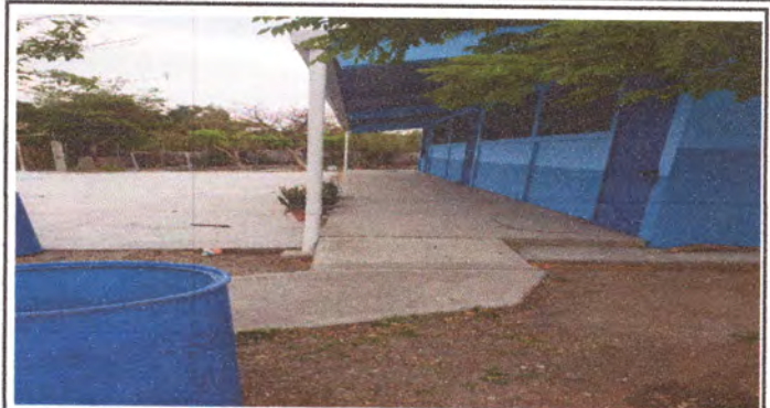
Foto 2: COLOCACION DE BAJADAS DE AGUA Y SUS ACCESORIOS
