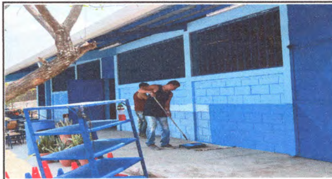
Foto 4: APLICACIÓN DE PINTURA EN AULAS POR DENTRO Y FUERA
