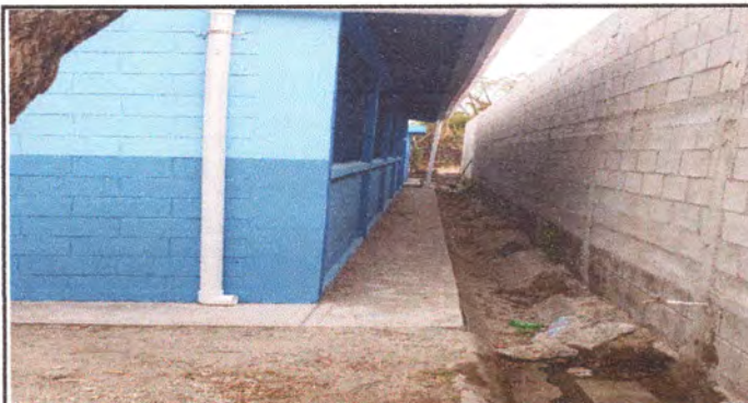
Foto 3: RESANADO DE CUMETA Y FUNDICION
