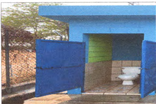
Foto 5: MANTENIMIENTO DE BAÑOS Y CAMBIO DE ACCESORIOS
