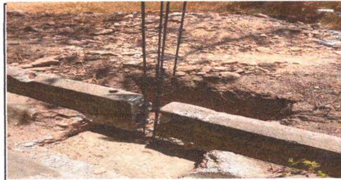
Foto 6: REEMPLAZO DE LA MALLA POR MURO DE BLOCK CON COLUMNAS Y SOLERAS Y ZAPARAS A UNA ALTURA DE 2.40MT DEL NIVEL DEL PISO
