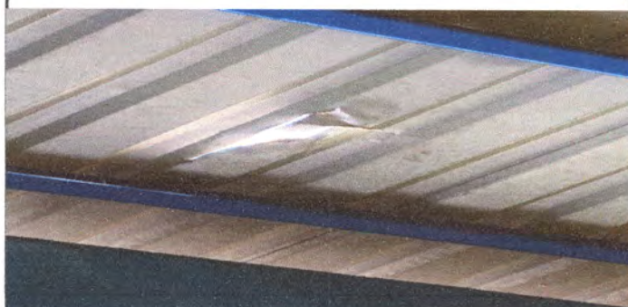
Foto1: REEMPLAZO DE LAMINAS DAÑADAS Y SELLADO DE ALGUNOS AGUJEROS CON TAPAGOTERA
