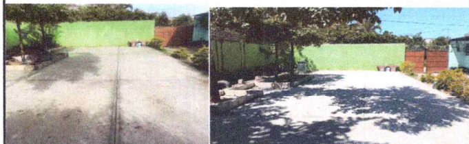
Foto 3: sustitución de losa de patio incluye base, fundición y acabado
