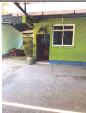
Foto 1: Sustrucción de ventanas
