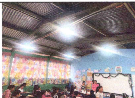
Foto 4: sustitución de lámparas led incluyendo interruptor
