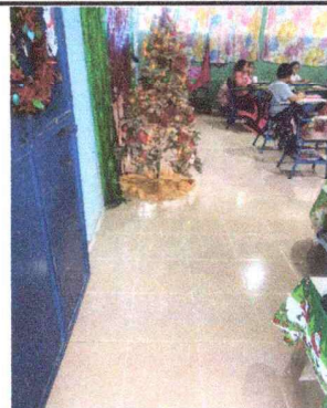
Foto 2: Sustrucción de piso cerámico incluye base de concreto
