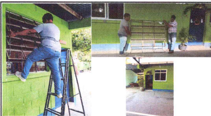
Foto 1: Sustitución de ventanas
