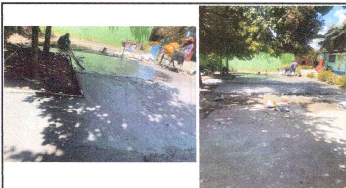
Foto 3: sustitución de losa de patio incluye base, fundición y acabado
