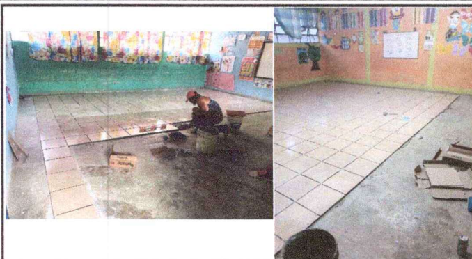
Foto 2: Sustitución de piso cerámico incluye base de concreto
