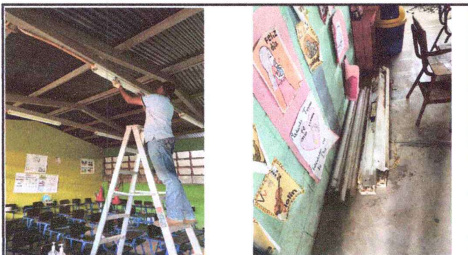
Foto 4: sustitución de lámparas led incluyendo interruptor
