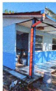
Foto 6: canales y bajadas de agua pluvial
