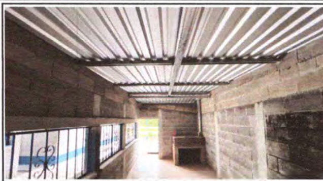
FOTO 2: CAMBIO DE ESTRUCTURA DE LA COCINA Y COMEDOR FINALIZADOS
