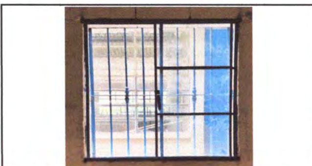
Foto 5: LAS VENTANAS EN EL AULA No. 4 FUERON COLOCADAS
