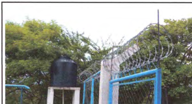
Foto 10: COLOCADO RAZOR RIBBON EN LA PARTE SUPERIOR DEL PORTÓN ENTRADA PRINCIPAL
