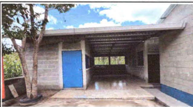
Foto 1: TRABAJOS COLOCACIÓN DE LÁMINA DE LA COCINA Y COMEDOR FINALIZADA
