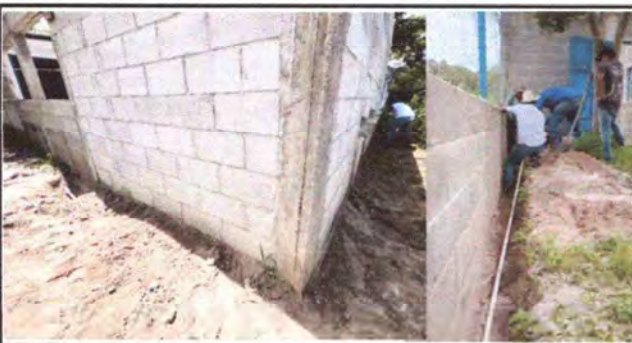
Foto 11: ZANJEO PARA LA RED DE TUBERÍA DE AGUA Y TRABAJOS PARA CONDUCCIÓN DE DRENAJES FINALIZADOS
