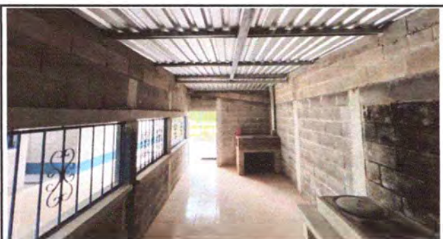
Foto 3: COLOCACIÓN DEL PISO EN EL ÁREA DE LA COCINA, COMEDOR Y AULA No. 4 FINALIZADOS
