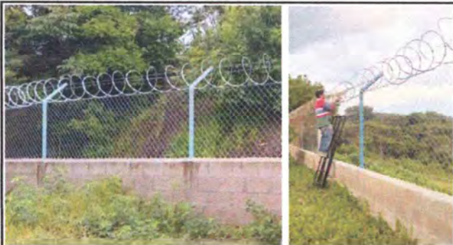
Foto 13: TRABAJOS EN EL ALAMBRE ESPIGADO QUE SOSTIENE EL RAZOR RIBBON DE LA MALLA FINALIZADOS
