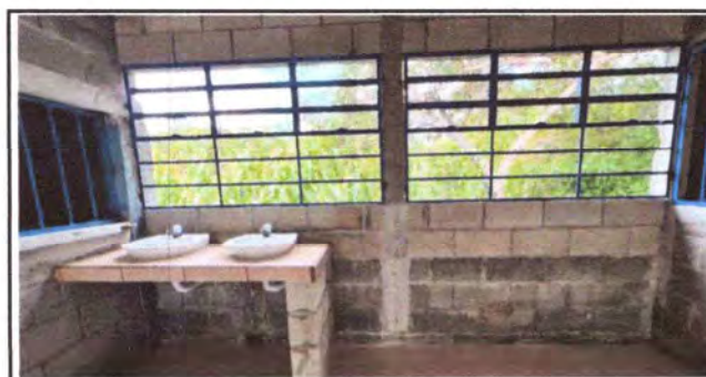
Foto 6: COLOCADAS LAS VENTANAS DE METAL TIPO BALCON (FIS)
