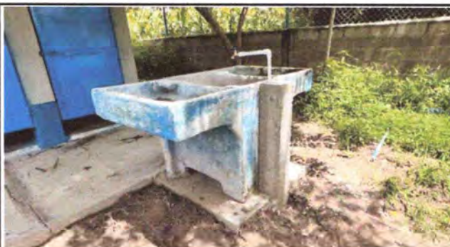
Foto 9: COLOCACIÓN DE PILA EXISTENTE EN EL ÁREA DE LETRINAS
