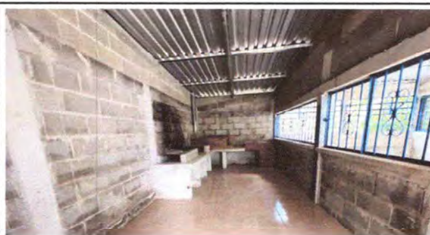
FOTO 14: TRABAJOS EN EL ÁREA DE COCINA Y ESTUFAS RURALES DE LEÑA CONCLUIDOS
