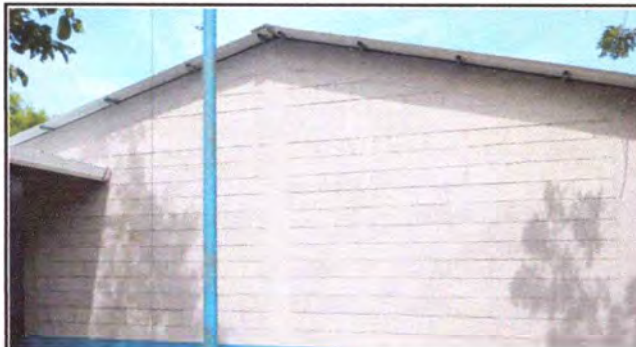
FOTO 8: REALIZADO EL TRABAJO DE PINTURA DEL MURO EXTERIOR
