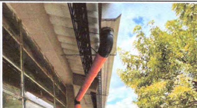
Foto 7: COLOCADOS PISCANTES PARA EL CANAL DEL TECHO POSTERIOR
