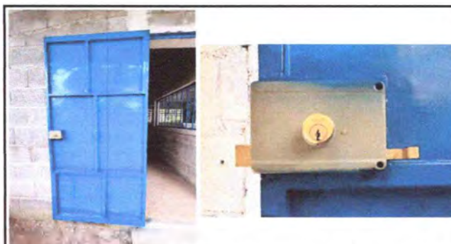
Foto 4: TRABAJO EN LAS PUERTAS DE LA COCINA, AULA No. 4 Y LAS CHAPAS REALIZADOS
