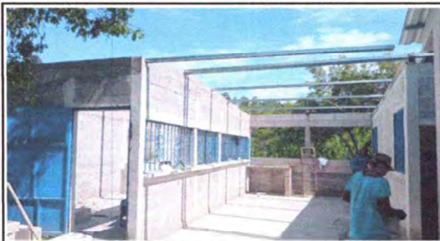
FOTO 2: CAMBIO DE ESTRUCTURA DE LA COCINA Y COMEDOR
