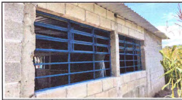
Foto 6: COLOCACIÓN DE VENTANAS DE METAL TIPO BALCON (FIS)
