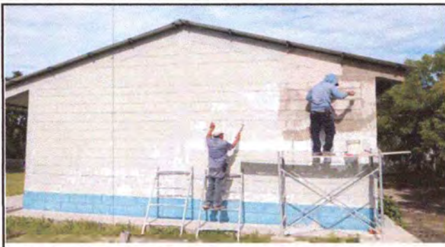
FOTO 8: LIMPIEZA DE LOS RESTOS Y TRATAMIENTO PARA LA PINTURA DEL MURO EXTERIOR
