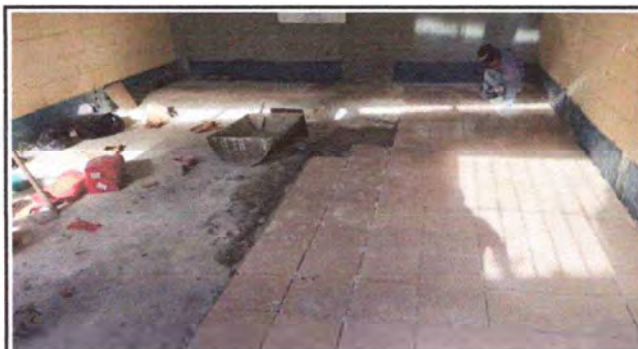
Foto 3: COLOCACIÓN DEL PISO EN EL ÁREA DE LA COCINA, COMEDOR Y AULA
