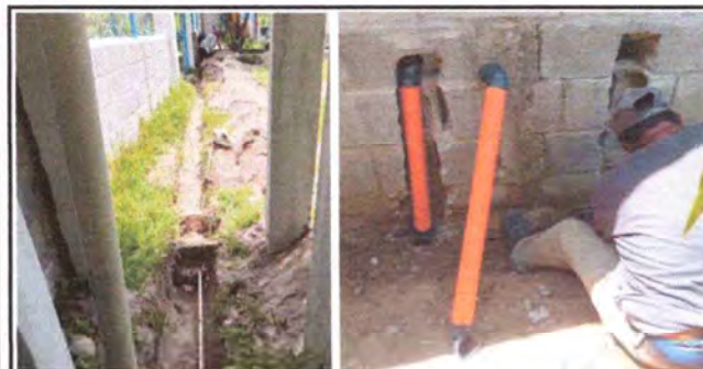
Foto 11: ZANJEO PARA LA RED DE TUBERÍA DE AGUA Y TRABAJOS PARA CONDUCCIÓN DE DRENAJES
