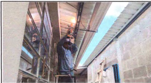
Foto 7: COLOCANDO PESCANTES PARA EL CANAL DEL TECHO POSTERIOR
