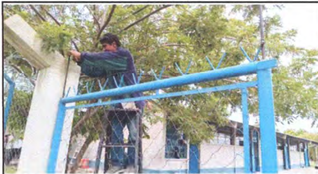
Foto 10: COLOCACIÓN DE BASES PARA ASEGURAR RAZOR RIBBON EN LA PARTE SUPERIOR DEL PORTÓN ENTRADA PRINCIPAL
