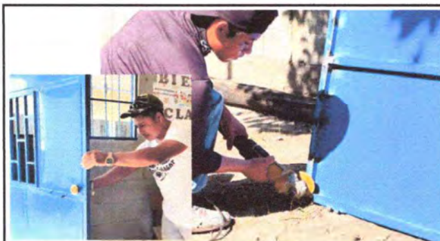
Foto 4: LAS PUERTAS DE LA COCINA, AULA No. 4 Y LAS CHAPAS ESTÁN SIENDO REPARADAS
