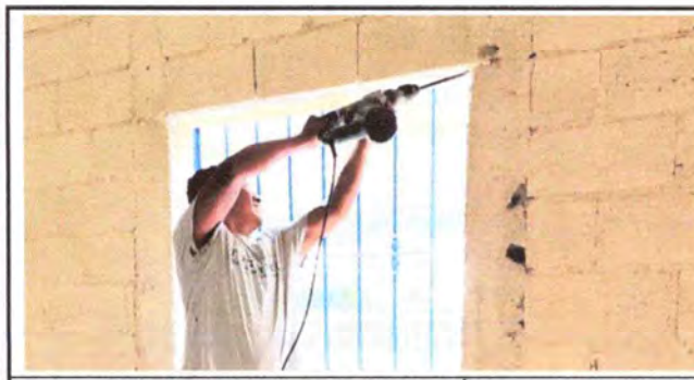
Foto 5: LAS VENTANAS EN EL AULA No. 4 ESTÁN SIENDO COLOCADAS
