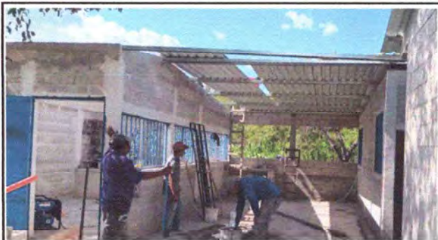
Foto 1: COLOCACIÓN DE LÁMINA DE LA COCINA Y COMEDOR
