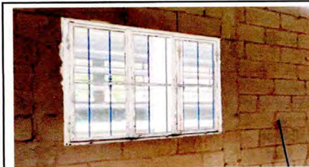
Foto 5: LAS VENTANAS NECESITAN CAMBIO PARA EVITAR SE META EL AGUA, POLVO Y VIENTO
