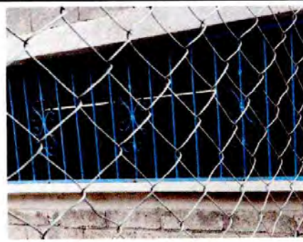
Foto 6: ESPACIO DE VENTANA CUBIERTA CON MALLA GALVANIZADA
