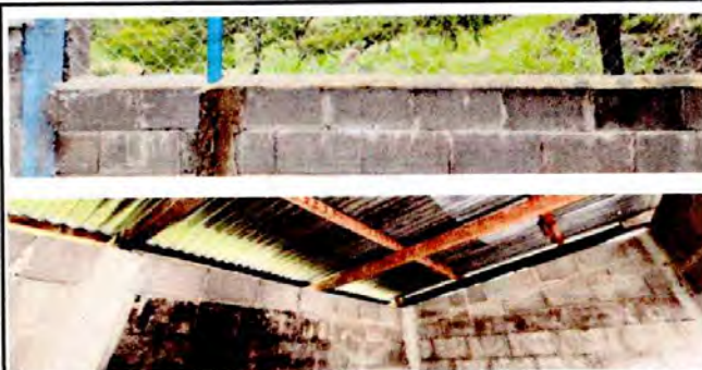
Foto 12: NIVELACIÓN DE PAREDES DEL MURO, COCINA Y AULA No. 4
