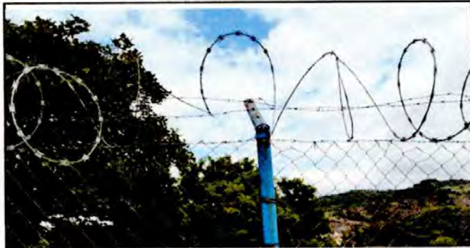
Foto 13: EL ALAMBRE ESPIGADO QUE SOSTIENE EL RAZOR RIBBON DE LA MALLA ESTÁ DAÑADO
