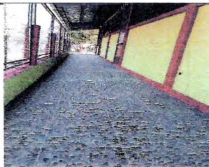
FOTO:6 Instalacion de piso de corredor
