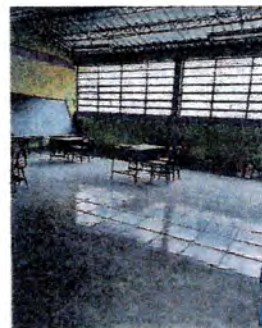
FOTO 4: INSTALACION DE PISO EN AULAS.
