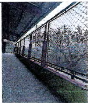
FOTO 3: MANTENIMIENTO DE MALLA
