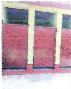
FOTO 5: Reparacion de puertas.
