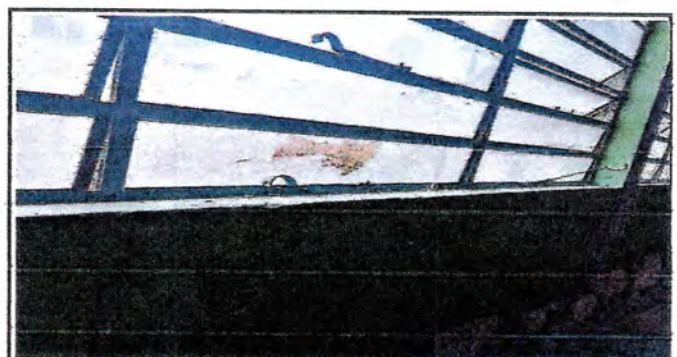
FOTO 4: MANTENIMIENTO Y REPARACION DE VENTANAS ROTAS.
