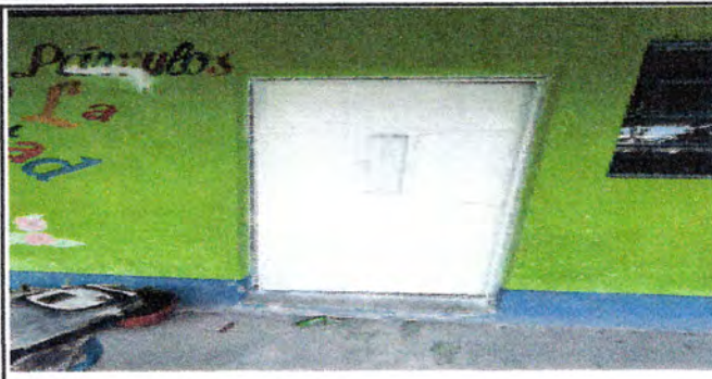
FOTO 2: Reparación de puertas.
