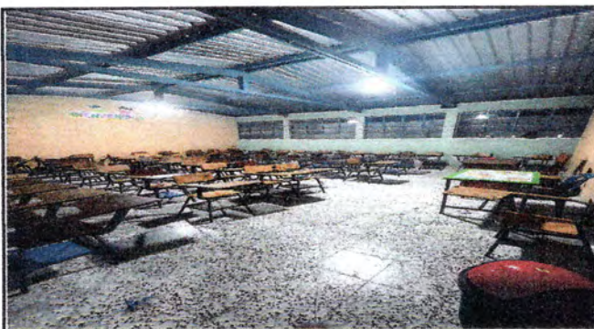
Foto 3: Instalación de piso.
