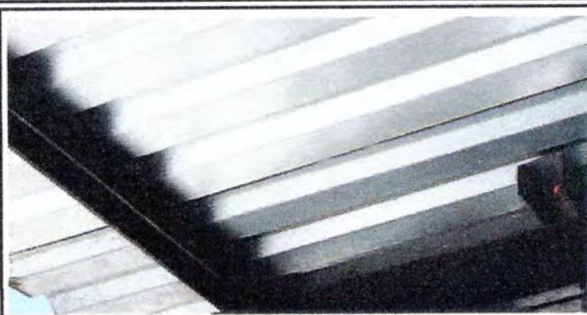
Foto 1: Reparación de techo, cambio de lámina.
