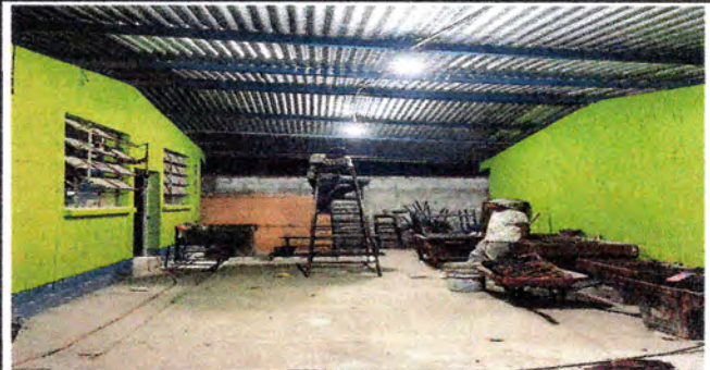
FOTO 8; Reparación de sistema eléctrico.
