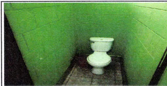
Foto 5: Cambio de sanitarios con accesorios.
