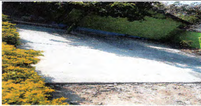
Foto 7: Losa en el patio.
