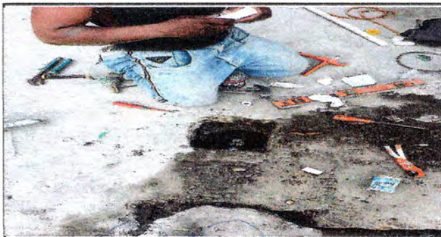
Foto 6: Reparación de drenajes y agua potable.
