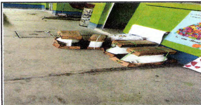
Foto 5: Cambio de sanitarios con accesorios.
