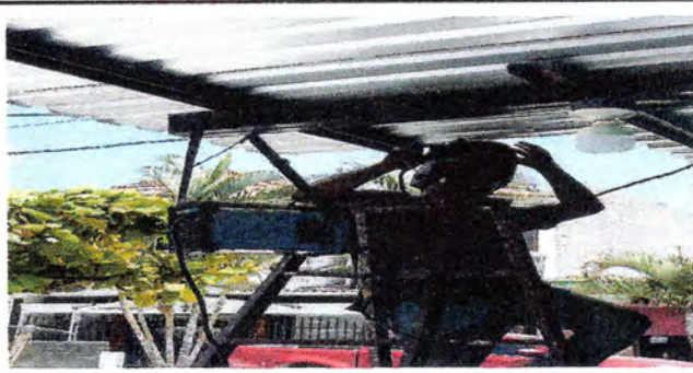
FOTO 8; Reparación de sistema eléctrico.
