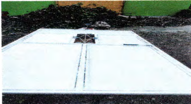
FOTO 2: Reparación de puertas.
