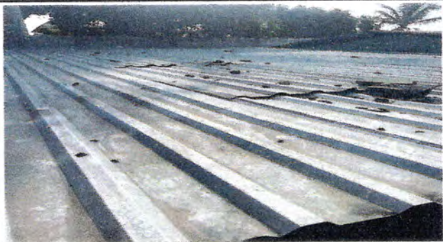
Foto 1: Reparación de techo, cambio de lámina.
