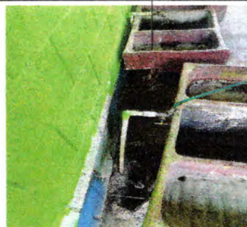
Foto 6: Reparación de drenajes y agua potable.
