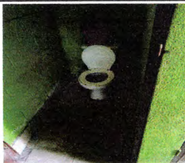
Foto 5: Cambio de sanitarios con accesorios.
