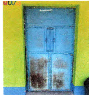
FOTO 2: Reparación de puertas.
