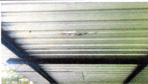
Foto 1: Reparación de techo, cambio de lámina.
