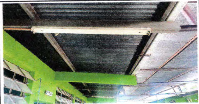
FOTO 8; Reparación de sistema eléctrico.
