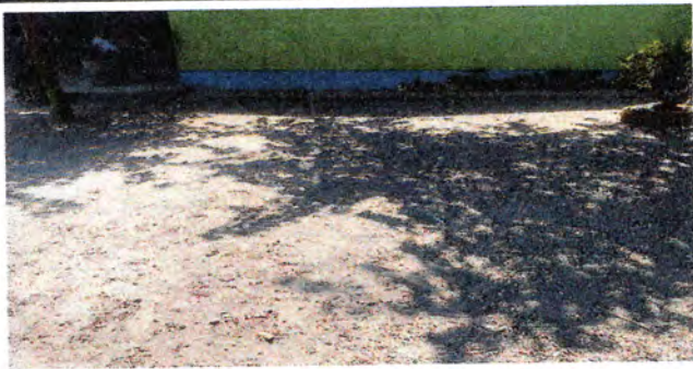
Foto 7: Losa en el patio.
