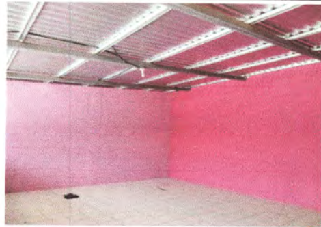
FOTO 2: Cubierta de lámina y estructura de techo, levantado de 30 cm de pared
