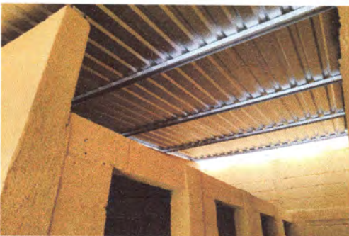
Foto: 5 muro perimetral
