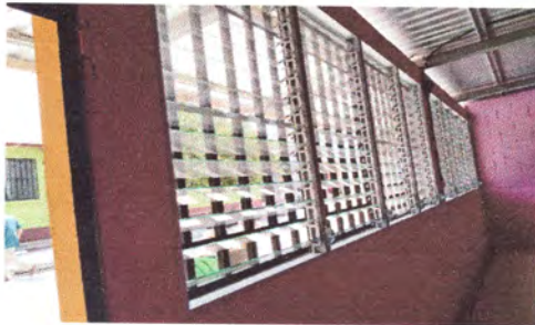
Foto3: Reparación de ventanas
