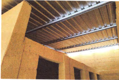
Foto1: cubierta de lamina y estructura de techo
