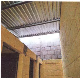
Foto1: cubierta de lamina y estructura de techo
