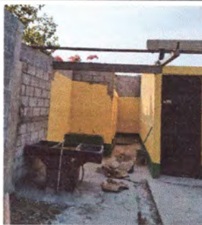
Foto: 5 muro perimetral
