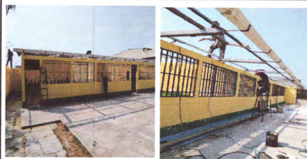
FOTO 2: Cubierta de lámina y estructura de techo, levantado de 30 cm de pared
