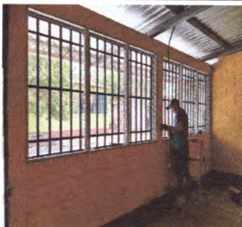
Foto3: Reparación de ventanas
