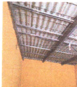
Foto 2: Cubierta de lámina y estructura de techo, levantado de 30 cm de pared
