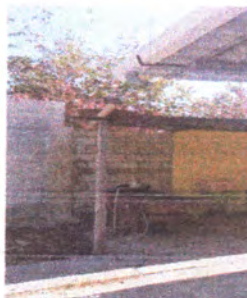
Foto 6: Canales y bajada de agua fluvial
