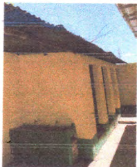
FOTO 1: Cubierta de lámina y estructura de techo
