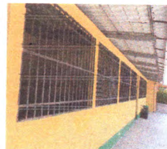
Foto 2: Cubierta de lámina y estructura de techo, levantado de 30 cm de pared
