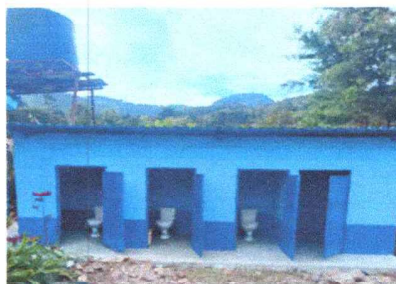
Foto 4: SERVICIOS SANITARIOS Y SUS ACCESORIOS
