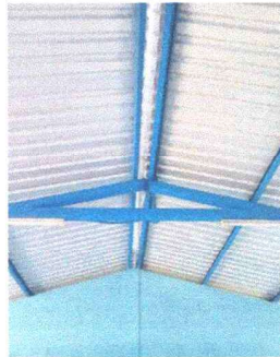
Foto 2: ESTRUCTURA DE TECHO
