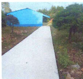
Foto 5: LOSA DE PATIO
