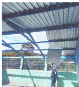
Foto1: CUBIERTA DE LAMINA
