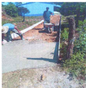
Foto 5: LOSA DE PATIO
