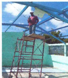
Foto 2: ESTRUCTURA DE TECHO
