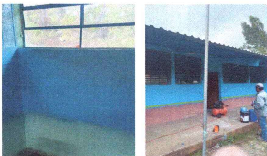
Foto 3: PINTURA EN MUROS INTERIORES Y EXTERIORES
