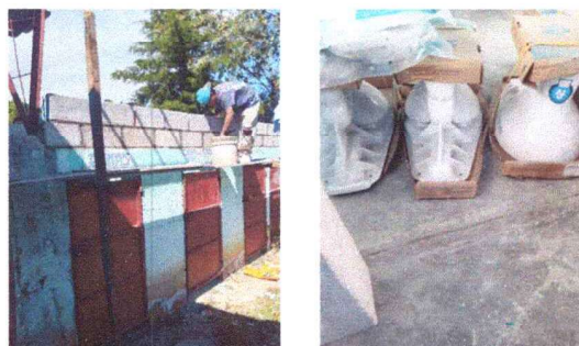
Foto 4: SERVICIOS SANITARIOS Y SUS ACCESORIOS
