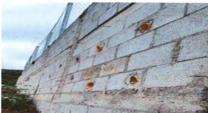
Foto 3: Reparación y mantenimiento posterior de cerco perimetral con malla 200mts2
