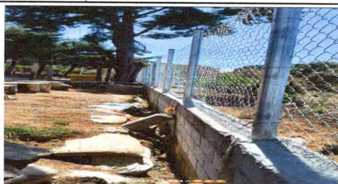
Foto 2: Reparación y mantenimiento posterior de cerco perimetral con malla 200mts2
