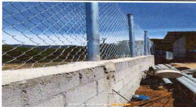
Foto 1: Reparación y mantenimiento posterior de cerco perimetral con malla 200mts2
