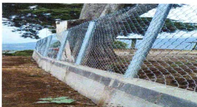
Foto 4: Reparación y mantenimiento posterior de cerco perimetral con malla 200mts2
