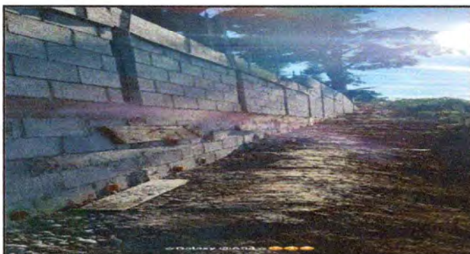
Foto 3: Reparación y mantenimiento durante el proceso de cerco perimetral con malla 200mts2
