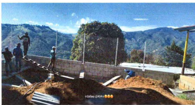
Foto 5: Reparación y mantenimiento durante el proceso de cerco perimetral con malla 200mts2
