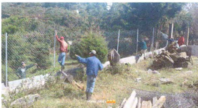
Foto 4: Reparación y mantenimiento durante el proceso de cerco perimetral con malla 200mts2
