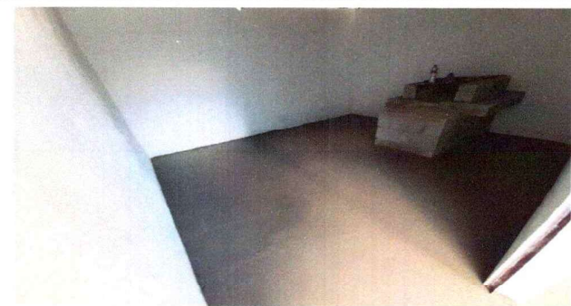
Foto 3: REPARACIÓN CONCRETO DE COCINA
