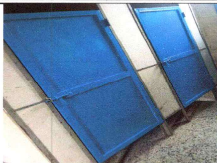
Foto 2: MANTENINIMIENTO PUERTAS DE BAÑOS
