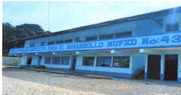
Foto 4: PINTURA INTERIOR Y EXTERIOR
