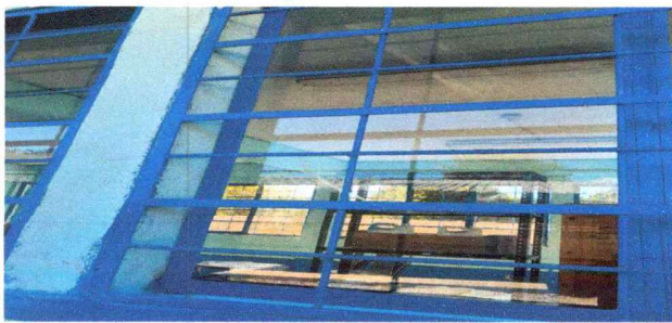
Foto 6: VENTANALES SEGUNDO PISO
