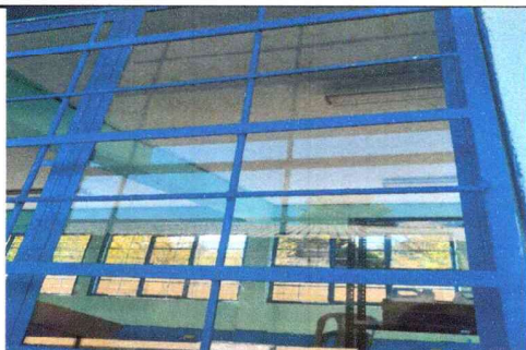
Foto 5: VENTANALES PRIMER PISO
