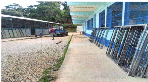
Foto 2: Colocación de marcos de ventanas
