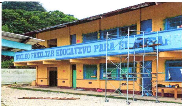
Foto 3: Pintura interior y exterior
