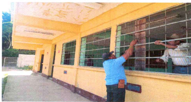
Foto1: Desmontaje de madera
