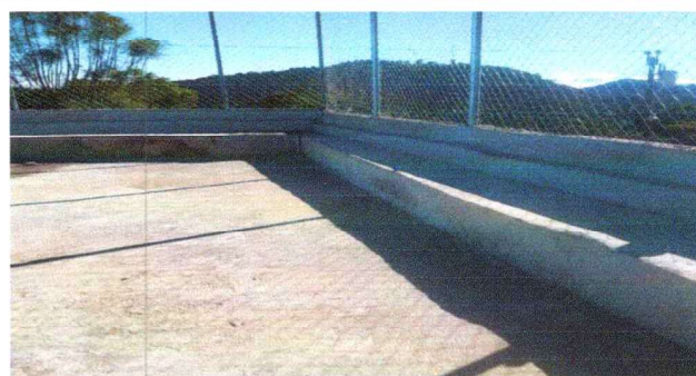
Foto 4: LOSA DE PATIO
