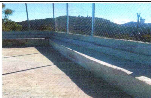
Foto 3: CERCO DE MURO PERIMETRAL
