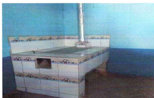
Foto 5: REPARACIÓN O SUSTITUCIÓN DE AREA DE COCINA (ESTUFA, CHIMENEA, PLANCHA, PINTURA, AZULEJO, PLANCHA.)
