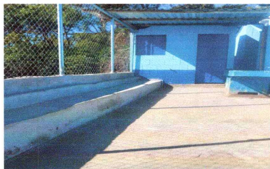
Foto 2: REPARACIÓN DE RED DE DRENAJES Y RED DE AGUA POTABLE
