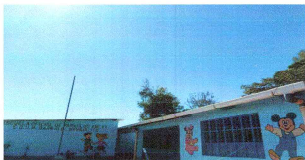
Foto1: PINTURA EN MUROS INTERIORES Y EXTERIORES
