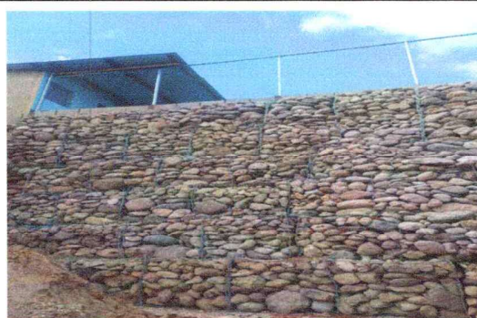
Foto 6: REPARACIÓN DE MURO DE CONTENCIÓN
