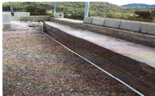
Foto 4: LOSA DE PATIO
