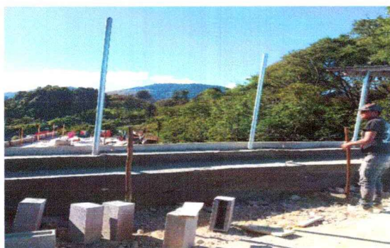
Foto 3: CERCO DE MURO PERIMETRAL
