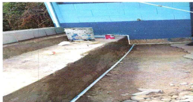
Foto 2: REPARACIÓN DE RED DE DRENAJES Y RED DE AGUA POTABLE
