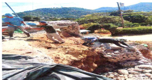
Foto 6: REPARACIÓN DE MURO DE CONTENCIÓN
