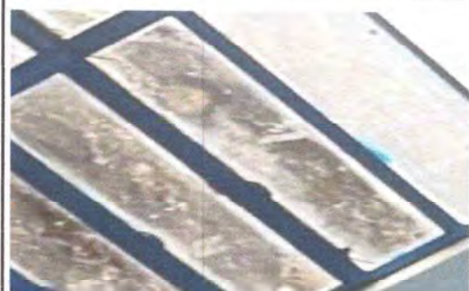
FOTO 4.1: SUSTITUCION DE VIDRIOS MEDIDAS TÍPICAS.
