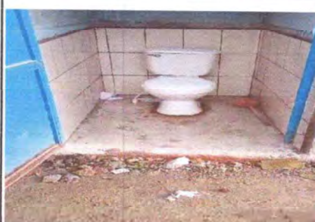
FOTO 7.1: SUSTITUCION DE SANITARIOS COMPLETOS.
