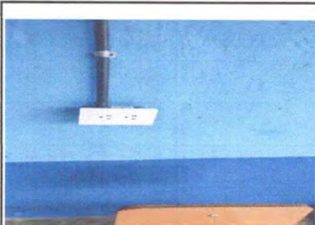
FOTO 10.2: SUSTITUCION DE TOMACORRIENTE.
