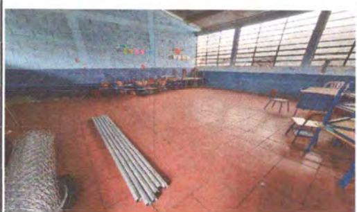
FOTO 5.1: SUSTITUCION PISO CERAMICAS.
