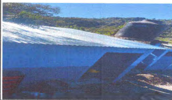
FOTO 1.1: SUSTITUCION LAMINA TROQUELADA CALIBRE 26
