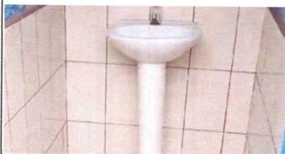
FOTO 7.2: SUSTITUCION DE LAVAMANOS CON PEDESTAL.
