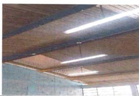
FOTO 10.1: SUSTITUCION DE LAMPARAS LED.
