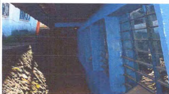
FOTO 4.1: SUSTITUCION DE CANALES Y BAJADAS 4".
