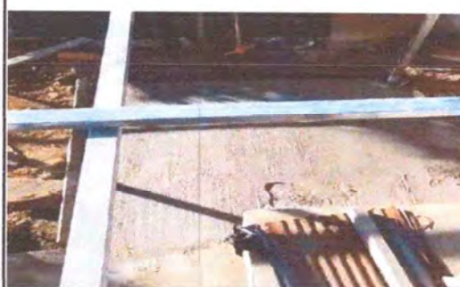
FOTO 2.1: REPARACION Y MANTENIMIENTO DE ESTRUCTURA SE PINTARA LA ESTRUCTURA Y SE REPARA.
