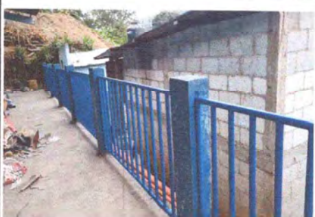
FOTO 8.1: REPARACION Y MANTENIMIENTO A BARANDA.
