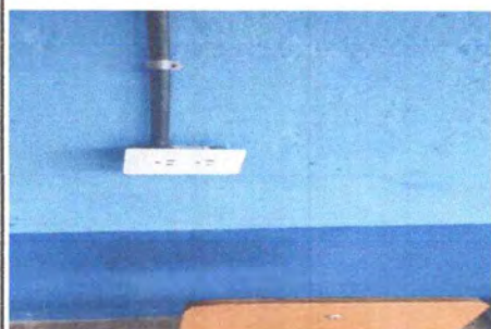
FOTO 10.2: SUSTITUCION DE TOMACORRIENTE.
