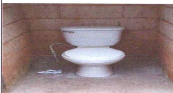
FOTO 7.1: SUSTITUCION DE SANITARIOS COMPLETOS.
