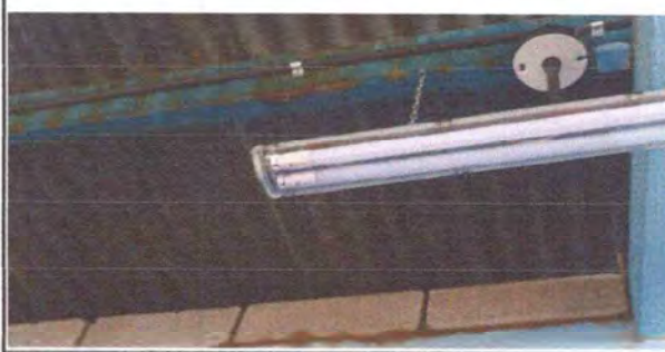
FOTO 10.1: SUSTITUCION DE LAMPARAS LED.
