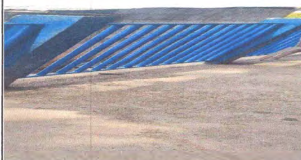
FOTO 8.1: REPARACION Y MANTENIMIENTO A BARANDA.
