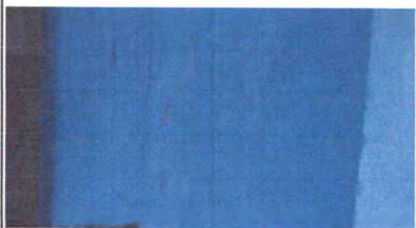
FOTO 6.1: SUSTITUCION DE PINTURA A BASE DE AGUA.
