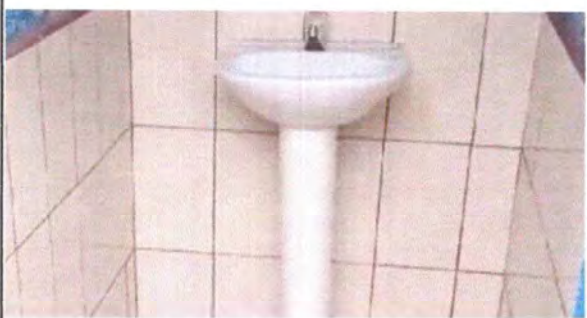
FOTO 7.2: SUSTITUCION DE LAVAMANOS CON PEDESTAL.
