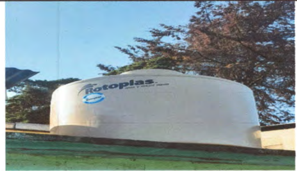
FOTO 8 : TERMINACION DE INSTALACION DE DEPOSITO DE AGUA Y SUS ASCCESORIOS
