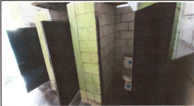
FOTO 7: TERMINACION DE INSTALACION Y PINTADO DE PUERTAS DE LOS BAÑOS DE HOMBRES Y MUJERES
