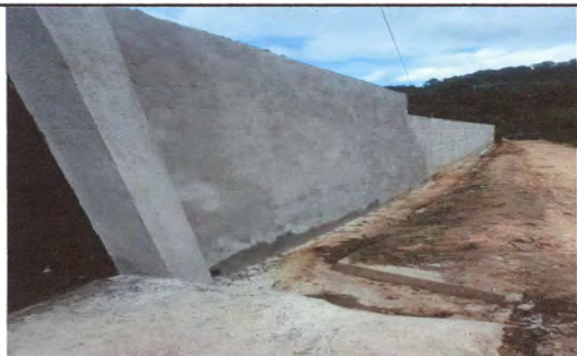
FOTO 3 : CUNETETA DE CONCRETO TERMINADA
