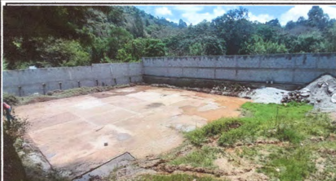
FOTO 1 : TERMINACION MURO DE CONTECIÓN Y CERCO PERIMETRAL INTERIOR
