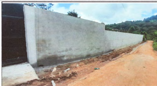
FOTO 2 : MURO DE CONTENCION Y CERCO PERIMETRAL EXTERIOR FINALIZADO
