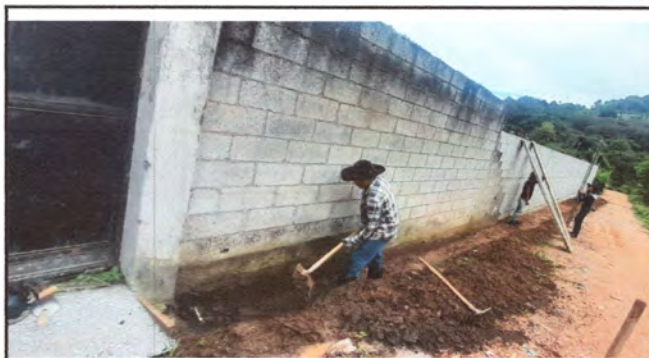
FOTO 4 : AVANCE DE CUNETA DE CONCRETO EXTERIOR
