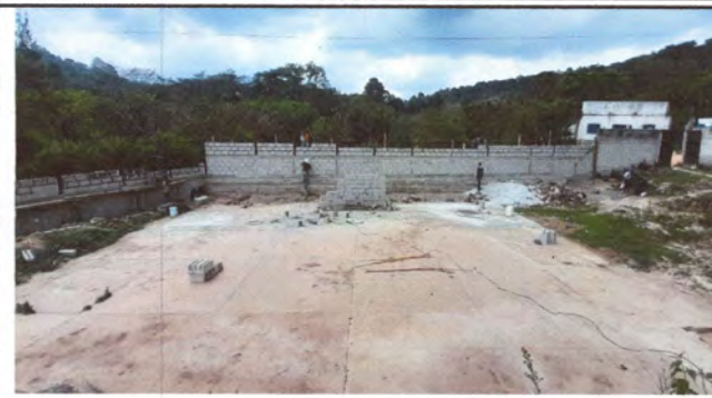
FOTO 2 : SE OBSERVA AVANCE DEL CERCO PERIMETRAL
