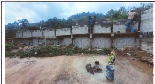
FOTO 3: AVANCE CERCO PERIMETRAL
