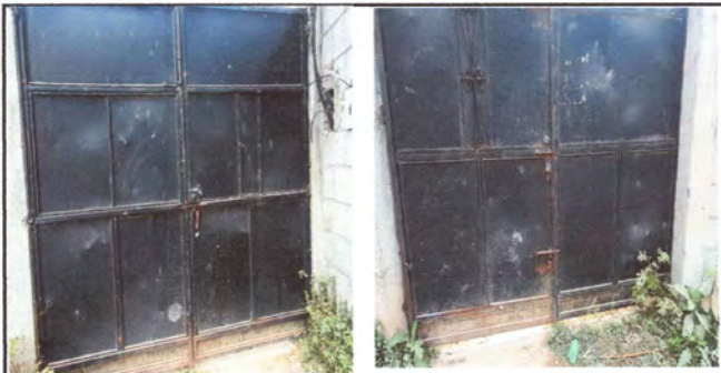
FOTO 12: PORTON PRINCIPAL DE LA ENTRADA DEL ESTABLECIMIENTO DETERIORADO
