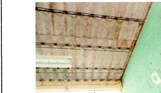
Foto 2: ESTRUCTURA DE TECHO
