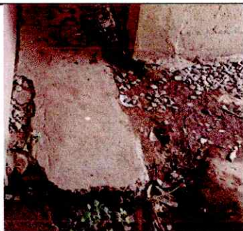
Foto 5: LOSA DE PATIO
