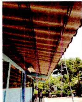
Foto1: CUBIERTA DE LAMINA
