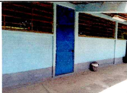
Foto 3: PINTURA EN MUROS INTERIOR Y EXTERIOR
