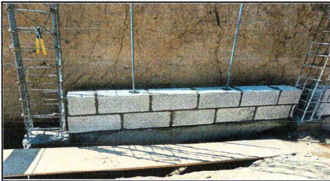
Foto 1: REPARACION DE MURO DE CONTENCIÓN
