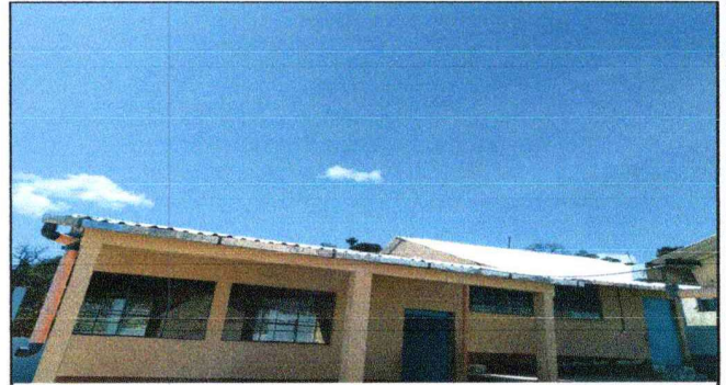
Foto 4: SUSTITUCIÓN DE LAMINA TROQUELADA C24
