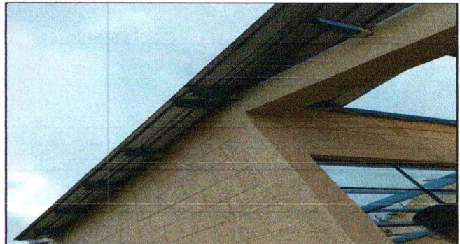
Foto 4: SUSTITUCIÓN DE LAMINA TROQUELADA C24
