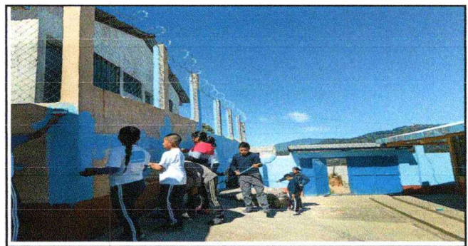
Foto 6: PINTURA DE MURO PERIMETRAL
