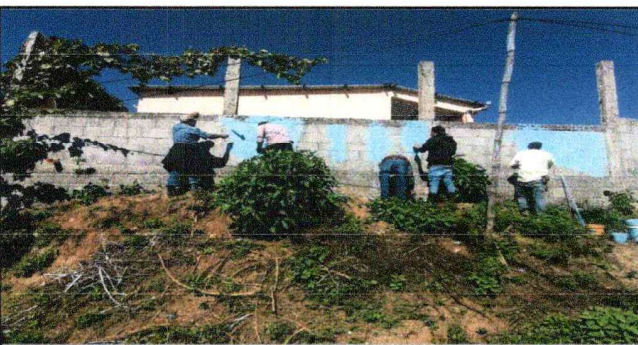
Foto 5: PINTURA DE MURO PERIMETRAL
