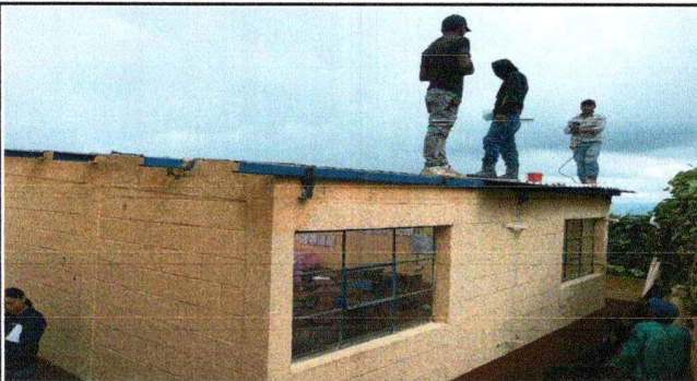
Foto 3: SUSTITUCIÓN DE LAMINA TROQUELADA C24
