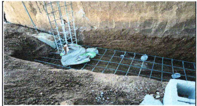
Foto 2: REPARACION DE MURO DE CONTENCIÓN
