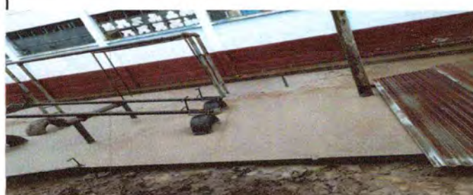
LOSA DE PATIO.
