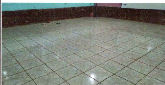
INSTALACION DE PISO.
