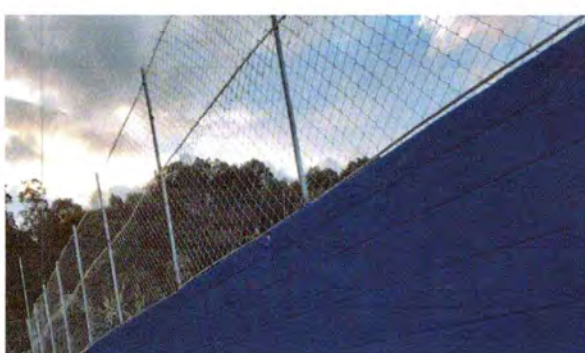
CERCO MURO DE MALLA.
