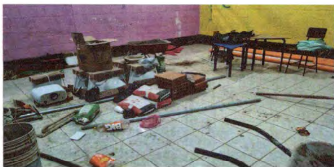
INSTALACION DE PISO.
