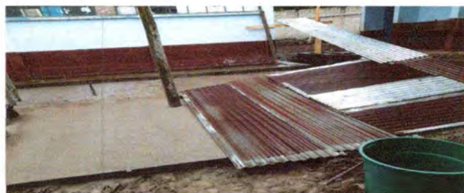
LOSA DE PATIO.
