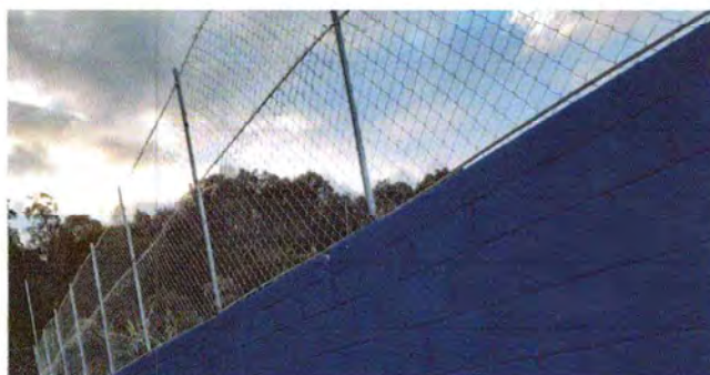
CERCO MURO DE MALLA.
