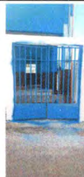
Foto 4: Reparación y mantenimiento de portón
