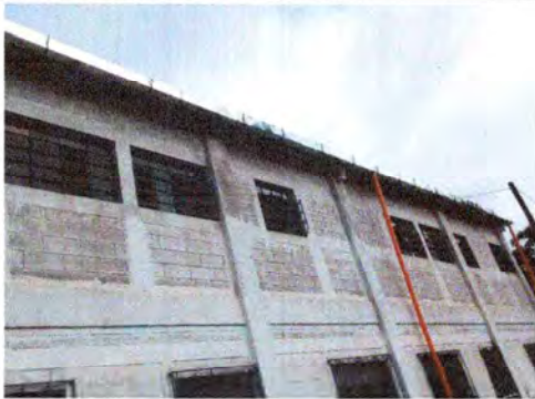
Foto 7: Sustrucción de canales
