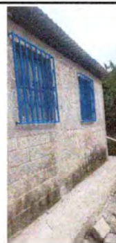
Foto 6: Sustitución de lámina troquelada y costanera
