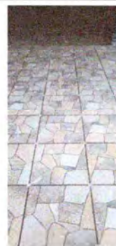
Foto 2: Sustitución de piso cerámico
